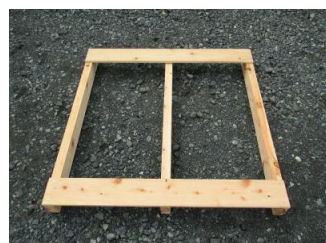
3 上板を2枚並べ、前と奥の上板の両端を釘で止めて下さい。
