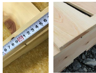
10 桁の50cmの所に印をつけて上板の真ん中と50cmの所で釘で止めて下さい。
