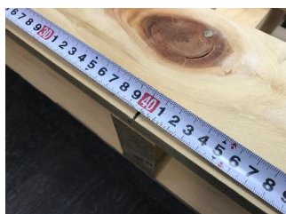
4 上板40cmに印を付け、真ん中の桁の芯と合わせて下さい。
