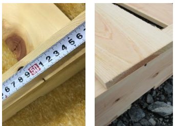
10 桁の50cmの所に印をつけて上板の真ん中と50cmの所で釘で止めて下さい。
